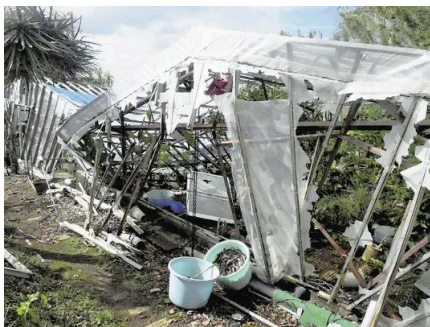
台風で激しく壊れた園芸農家のビニールハウス（いずれも 6 日、八丈町で）
